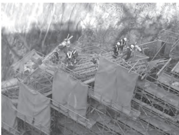
写真－5 堤趾導流壁コンクリート打設
