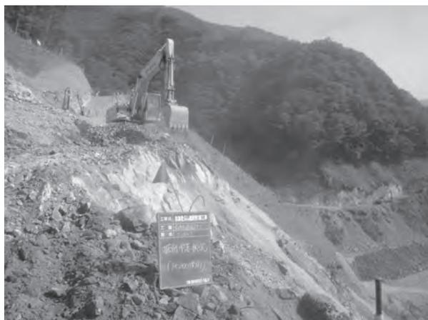
写真－2 堤体基礎掘削
