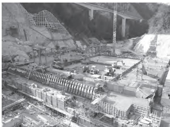
写真－4 本体コンクリート打設
