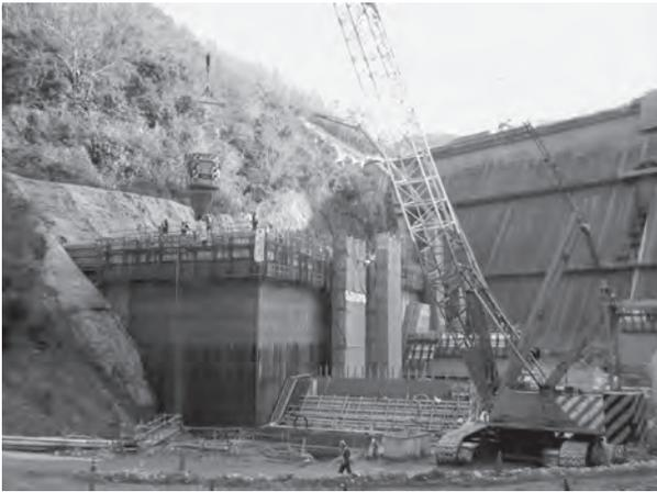
写真-6 減勢工コンクリート打設
