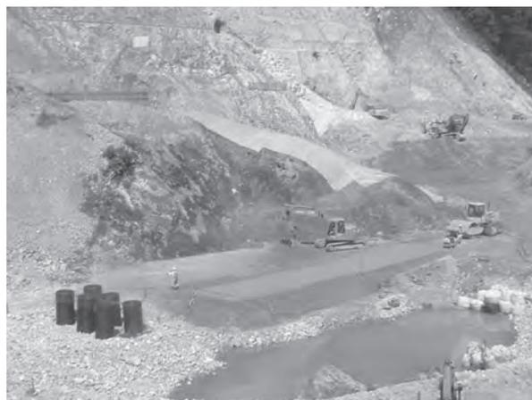
写真－3 仮設備造成盛土 (CSG)
