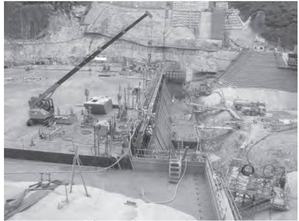
写真-7 鋼製型枠スライド
