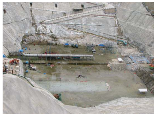
写真-6 岩着コンクリートと利水放流管
