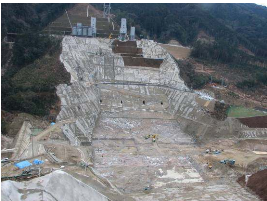
写真-5 粗掘削完了
