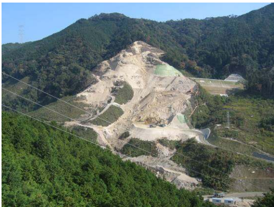
写真-3 左岸掘削状況
