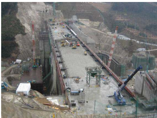
写真-24 巡航RCD工法全景
