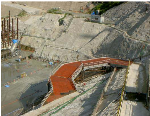
写真-22 構台式折り返し（堤体内）
