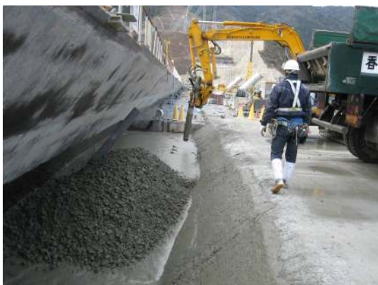
写真-26 外部コンクリート打設
