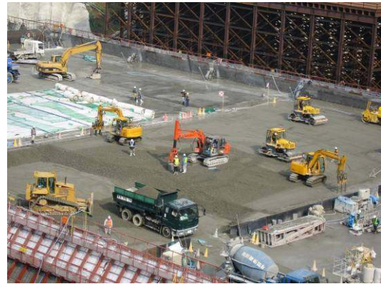
写真-8 打設状況
