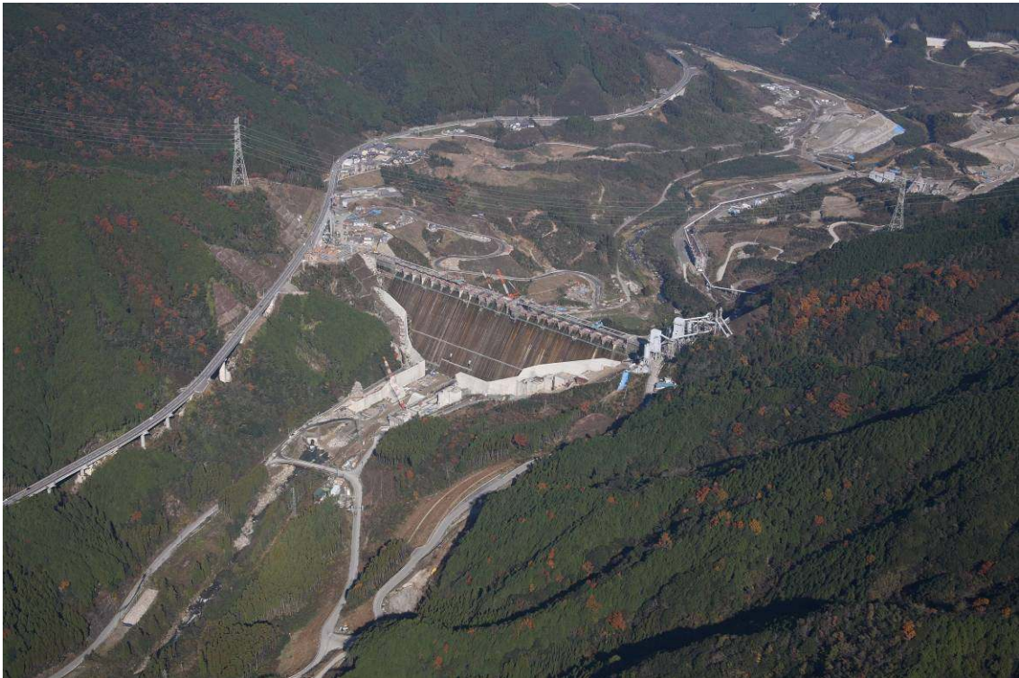
写真-1 堤体全景（平成 21 年 12 月撮影）
