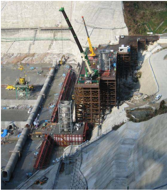
写真-19 利水放流縦管据付
