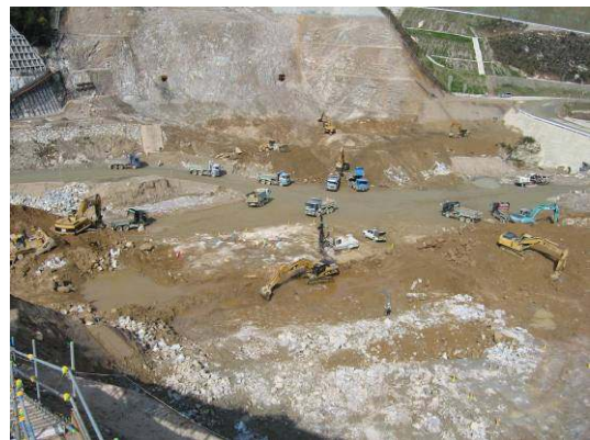
写真-4 河床部掘削状況
