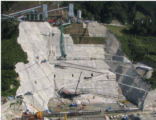
写真-21 堤体内道路全景
