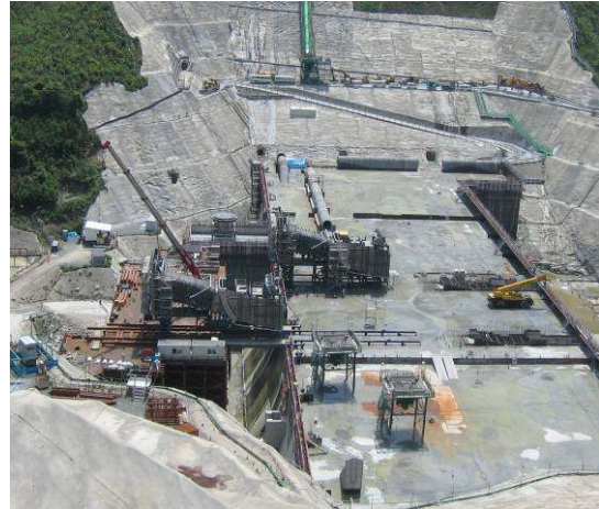
写真-20 常用洪水吐ゲート引き込み
