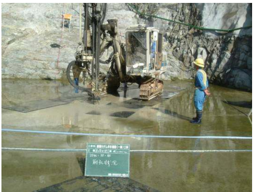
写真-11 河床コンクリートラッシングラッシング
