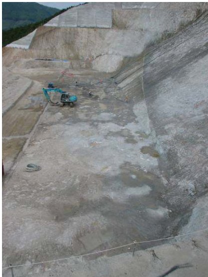
写真-13 左岸アバット
