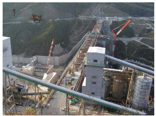
写真-10 堤頂部施工
