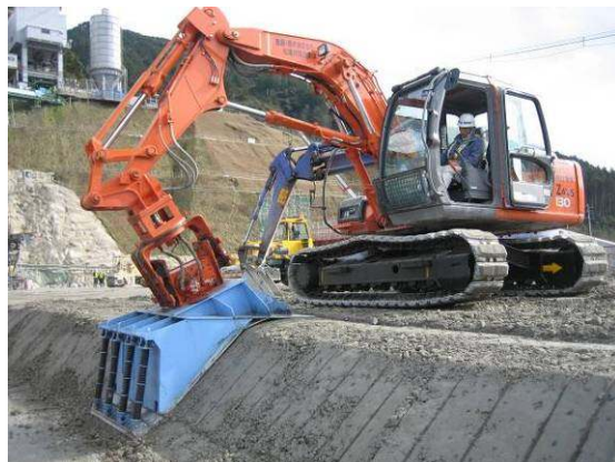
写真-25 RCDコンクリート法肩締め
