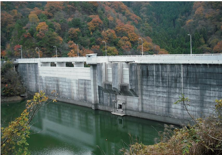
右岸より堤体上流面を望む (越流部 (L=49 m) 新設と天端橋梁(4 スパン)の状況)
