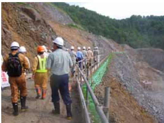
現場見学状況 夕張スーパーダム
