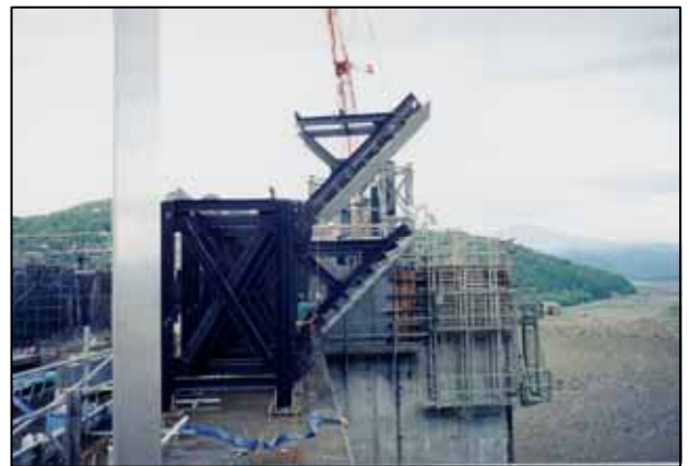
洪水吐張り出し部
