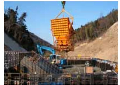
水平型バケツ (試作機)
