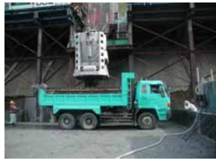
ケーブルクレーン打設において、ダンプトラックからバケツにコンクリートを移し替えるため、堤体斜面部に張り出し構台を設置して地下部にバケツ着床台を設けている。構台の設置・撤去作業、バケツの洗浄作業、荷こぼれコンクリートの清掃作業などが必要である。供給側が片岸に限定されるため、対岸側のコンクリート運搬時は能力低下、堤体上部通過時の安全性の確保対策の負担も大きい。
