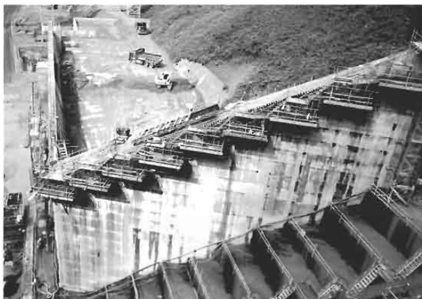
写真-10 波返し部のブラケット足場と支保工
