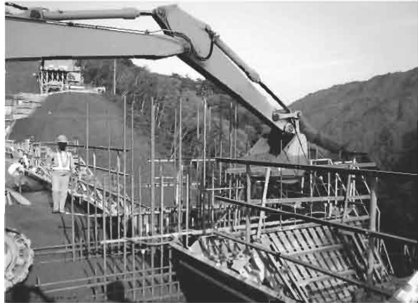
写真-8 導流壁部の打込み
