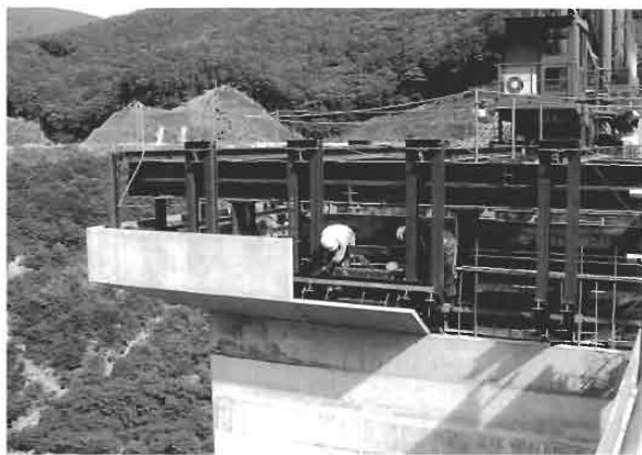
写真-6 構造物張出し部のプレキャスト
