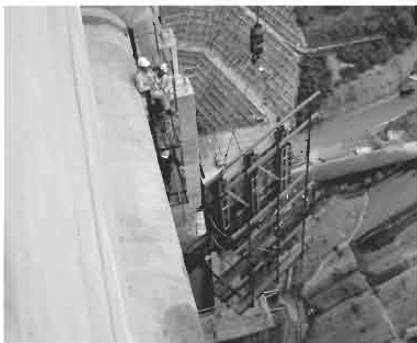
写真-13 張出し部の大型枠撤去作業
