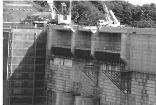
写真-15 上流面ブラケット撤去作業
