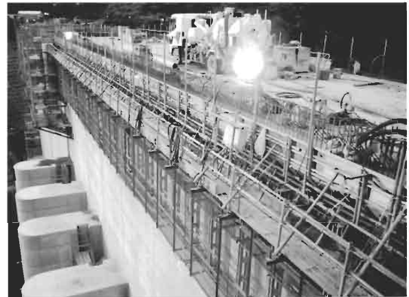
写真-2 地覆部の支保工と型枠
