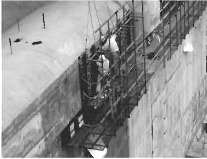
写真-12 張出し部の大型枠撤去作業
