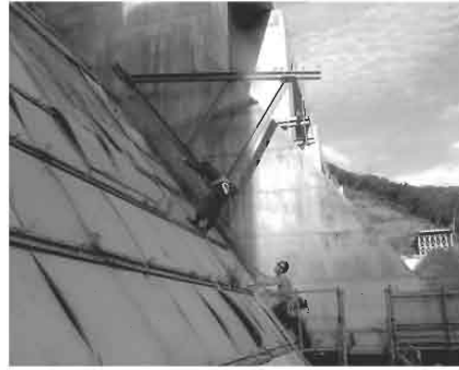
写真-14 下流面ブラケット撤去作業
