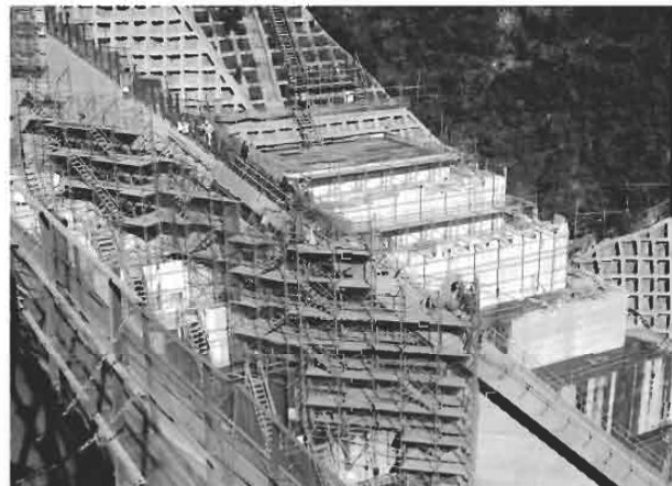
写真-11 波返し部の足場と支保工
