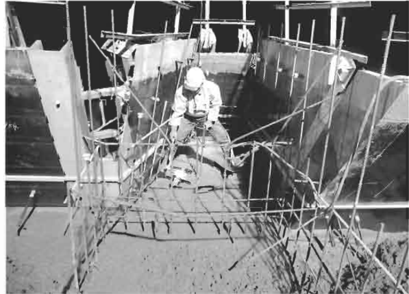
写真-9 導流壁部の人力締め
