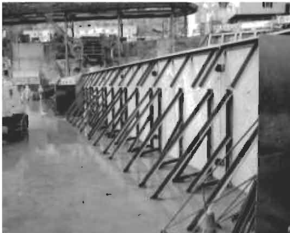
写真-2 プレキャストの固定 (堤体側)
