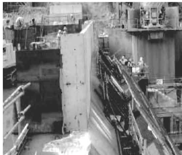
写真－1 勾配変化点にプレキャストを採用した例
