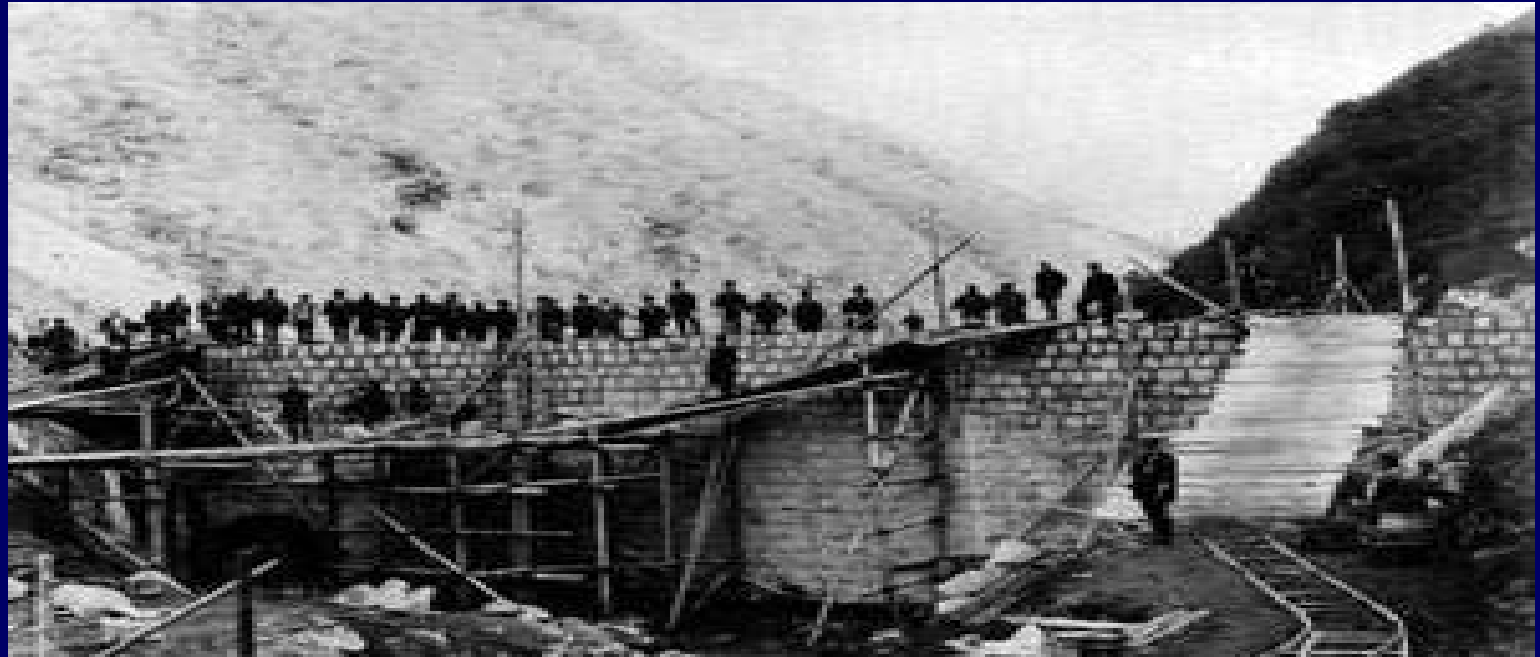
写真 建設当時の工事風景
