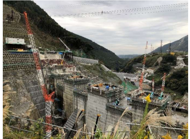
ダムサイト（上流右岸より）
