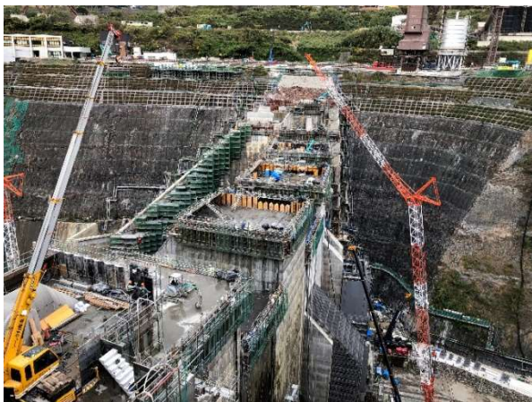
ダムサイト（左岸右岸より）
