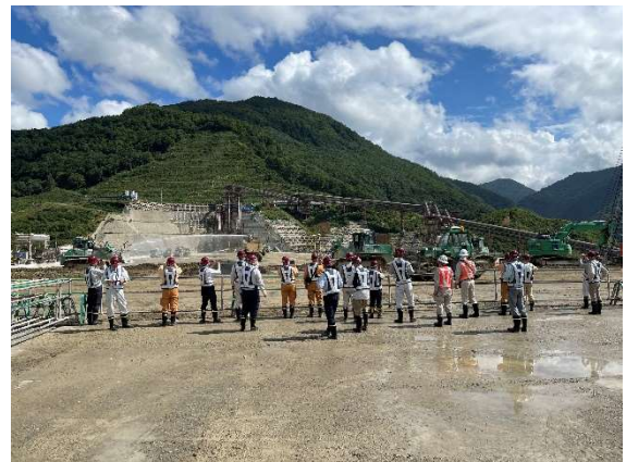
CSG 自動化施工状況
