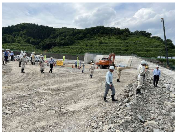
堤体盛立状況
