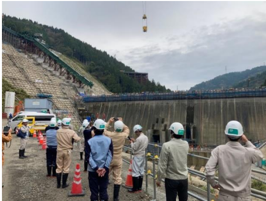
堤体コンクリート打設状況確認
