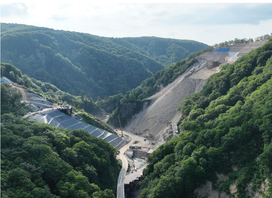
左：堤体下流より上流を望む、右：堤体上流より下流を望む 2025年6月末現在
